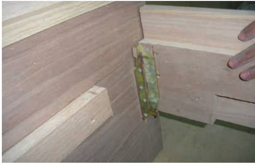
الشكل (٤-١): تثبيت المدادات مع الرأسية.
