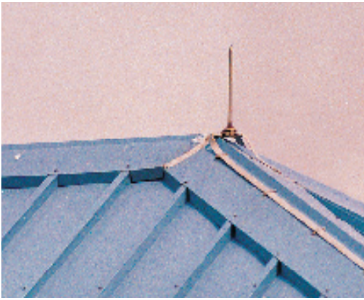
شكل 1 - 35 يمنع مانع الصواعق أي تلف محتمل لبناية خلال العواصف الرعدية.
